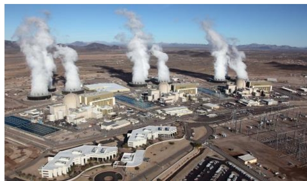
Figura 16: Fotografía de la Central Palo Verde. Fuente: Google, 2016
